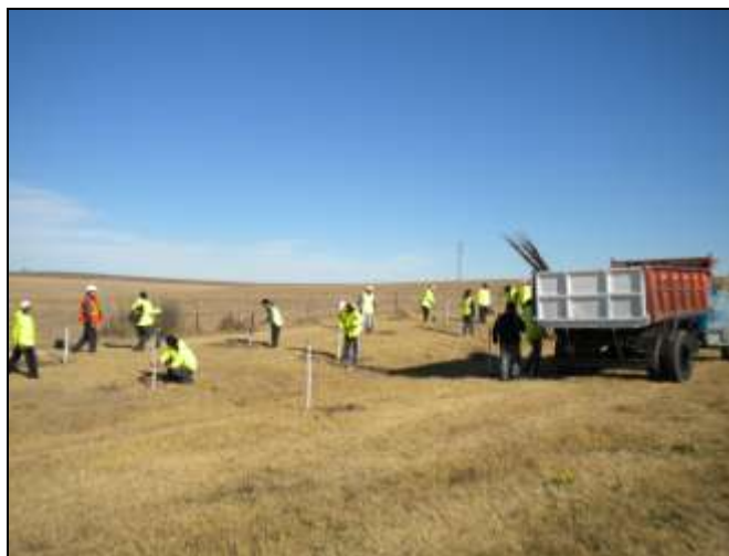
Cuadrillas de mantenimiento realizando labores de reposición.
